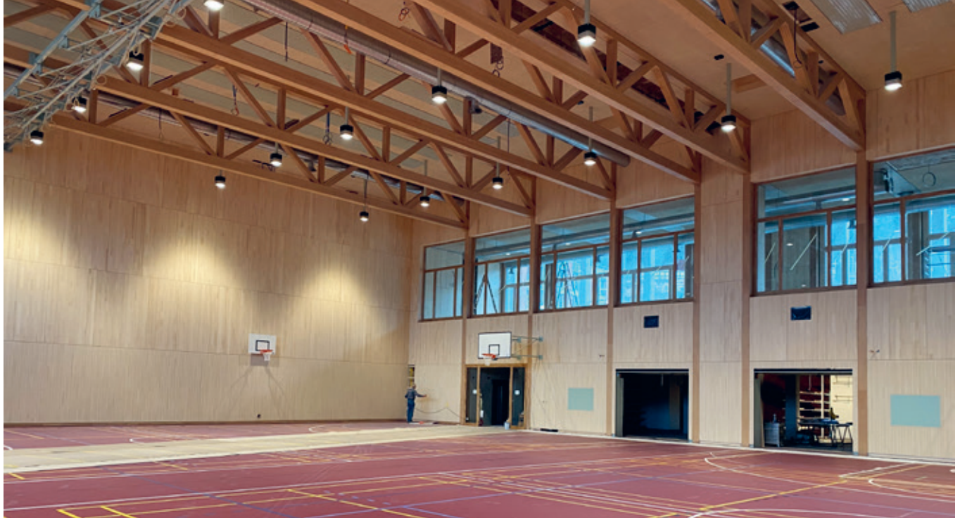
Holz dominiert das Innere der Turnhalle. Die knapp 29 Meter langen Fachwerkträger wurden von der Holzbau Oberholzer GmbH montiert.
