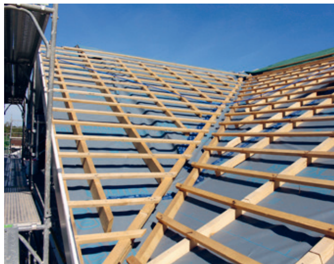
Energetische Dachsanierung in Allschwil mit der Unterdachbahn Solitex Quantho 3000 connect.
