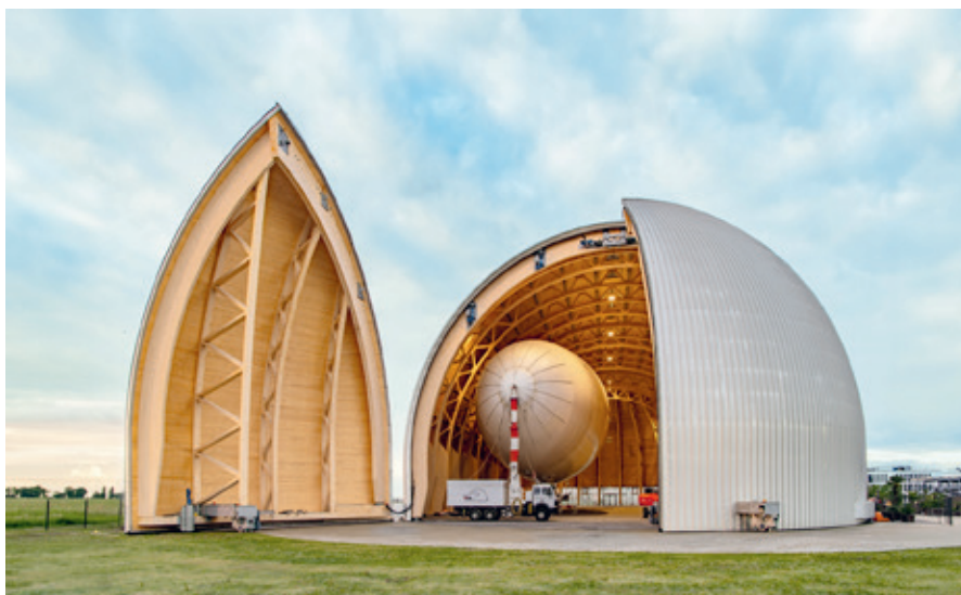
Die 72 Tonnen schweren Torflügel werden mit Motoren in Autogrösse bewegt.
