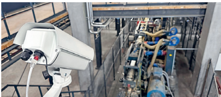
Im Säge- und Leimholzwerk von Schilliger Holz werden Kameras zur Brandfrüherkennung getestet.
