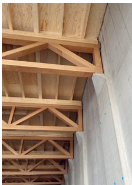
Auf einer Seite tragen elegante Betonauflager die mächtigen Fachwerkträger der Turnhalle.
