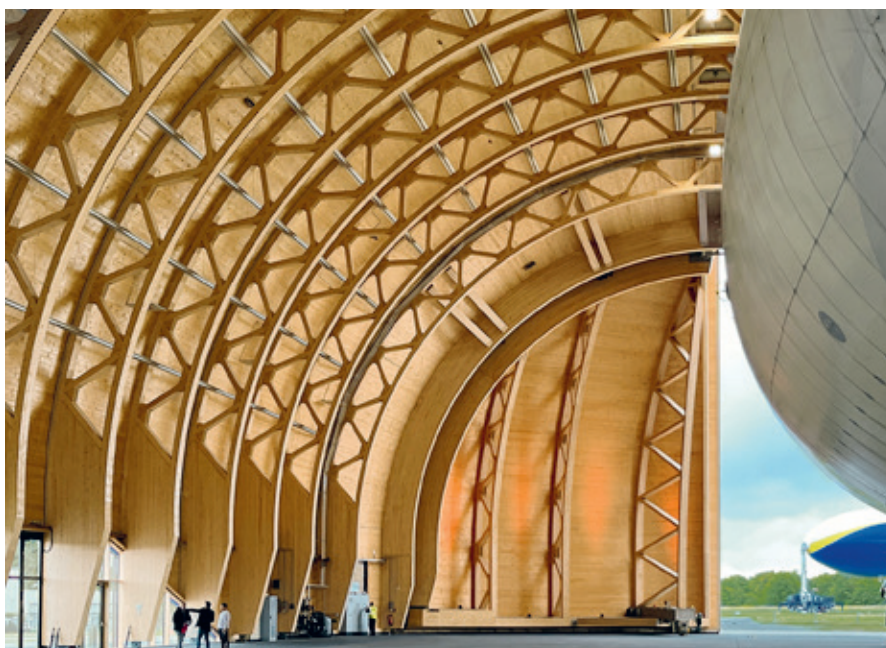
Das Primärtragwerk besteht aus 15 gebogenen Zwei-Gelenk-Rahmen.
