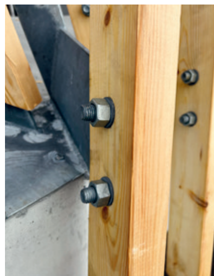
Die Verbindungen sind stets zugänglich.
