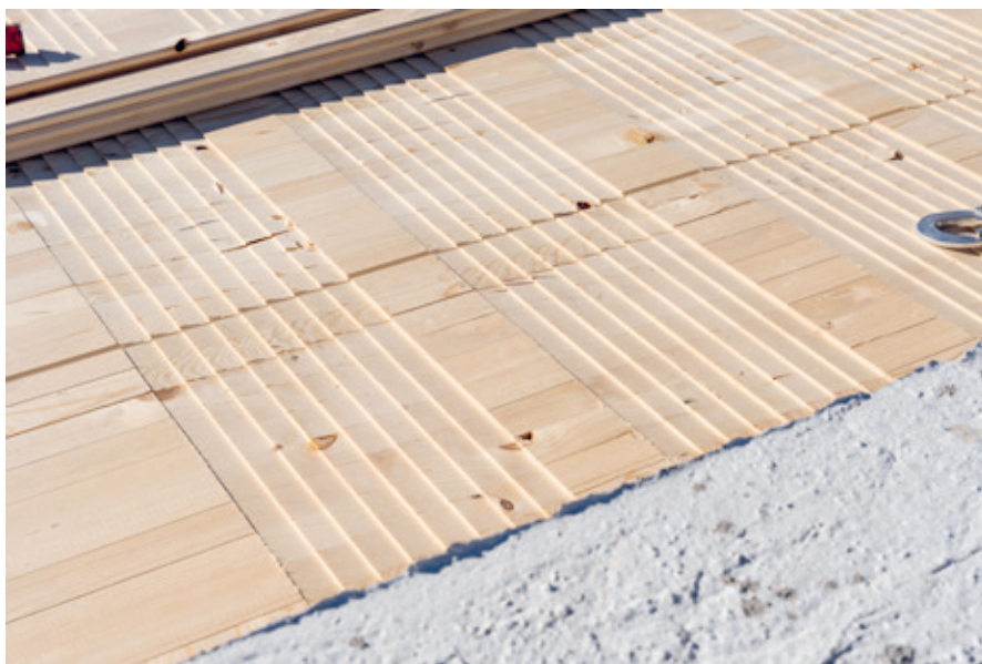
Mikrokerven für die Holz-Beton-Verbunddecken sind in der Herstellung einfacher, ökonomischer und auch ökologischer als herkömmliche Kerben.
