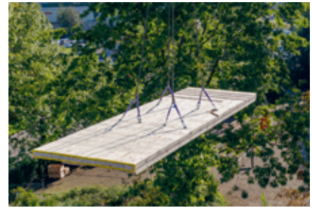
Die Brettstapeldecken, vorgefertigt von der Sidler Holz AG, wurden von den Zimmerleuten der F+W Holzbau AG montiert.
