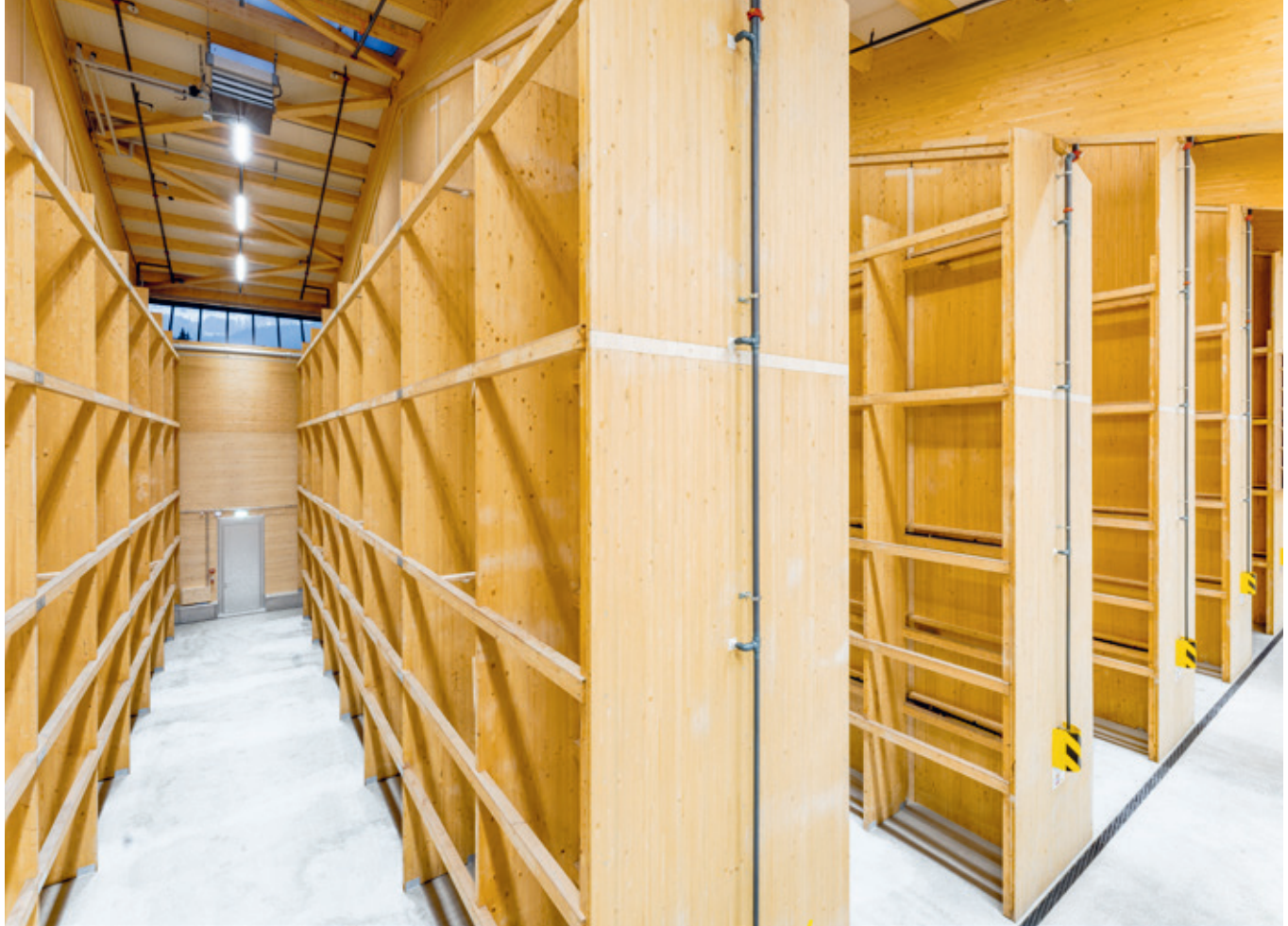
Die neuen Brandschutzvorschriften ermöglichen massgeschneiderte Konzepte, die auf das tatsächliche Risiko abgestimmt sind. Hier das Hochregallager aus Holz der Appenzeller Alpenbitter AG.
