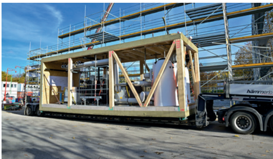
Blumer Lehmann aus Gossau lieferte die vorgefertigten Holzmodule nach Stuttgart.
