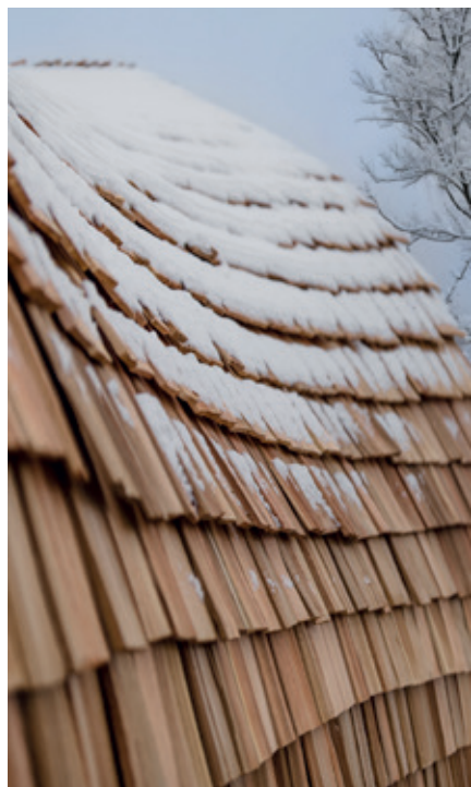
Das Schindeldach und zusätzliche Verstärkungsbögen gewährleisten Standfestigkeit bei Windspitzen von bis zu 160 km/h und Schneelasten von bis zu 8 Metern (800 kg/m²).
