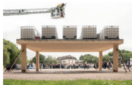
Der UniversalTimberSlab-Demonstrator in Remscheid (DE) – die weltweit erste punktgestützte HBV-Flachdecke.
